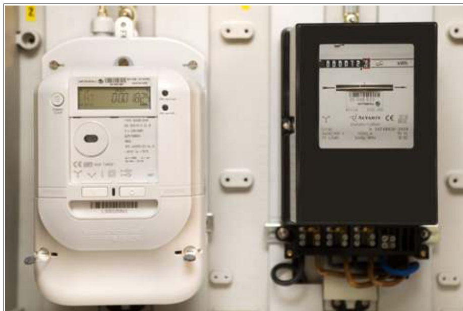
Abbildung 4: Smart Meter (links), Ferrariszähler (rechts) - Quelle: http://e-control.at
